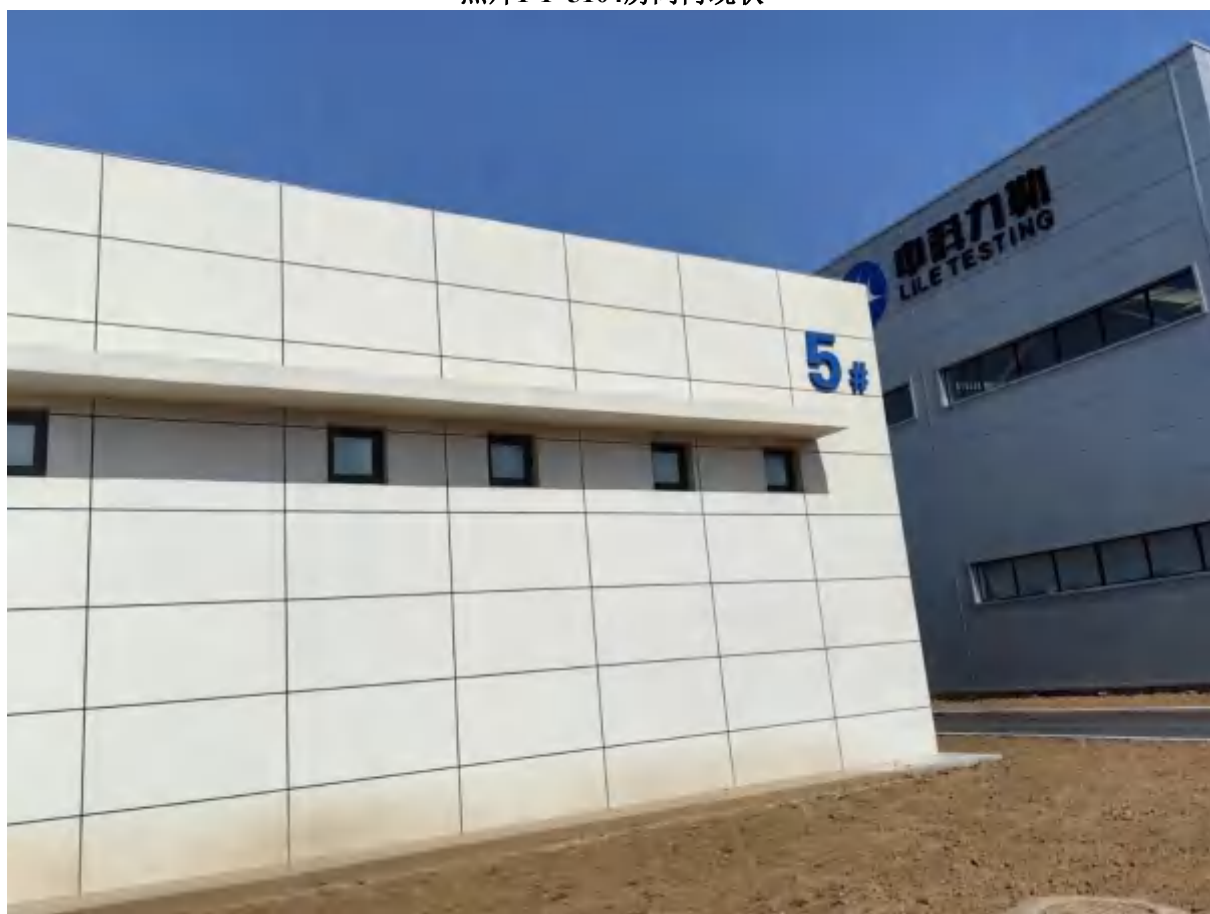
照片1-2 5#厂房外观
