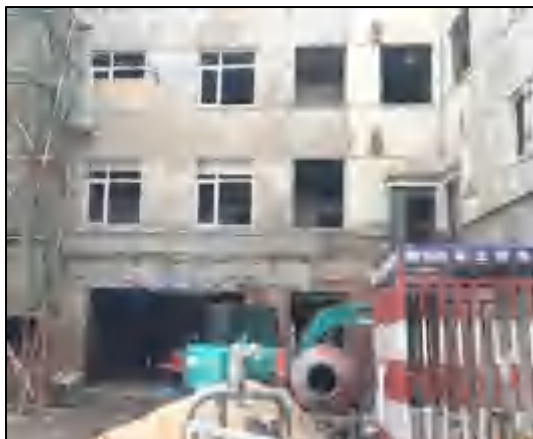
图 1-3 7 号楼外部现状
