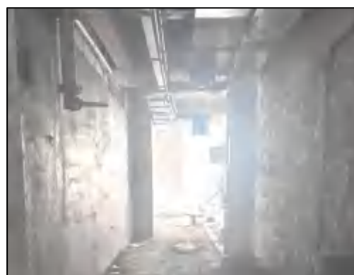
图 1-2 迷道内部现状
