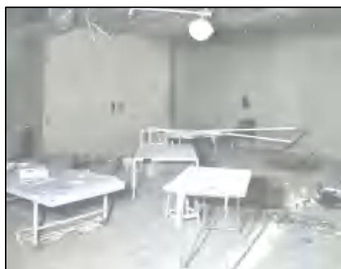
图 1-1 机房内部现状
