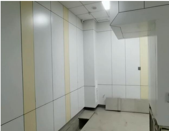
机房内迷道现状
