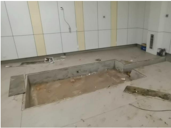
机房内部现状
