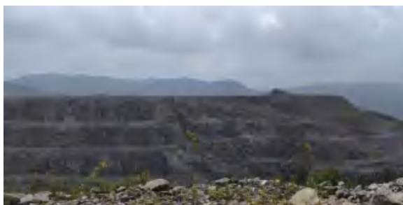
废石堆放场 1 边坡整形效果
